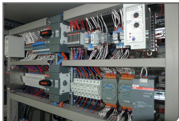
\* **Шкаф ввода аккумуляторной батареи (ШВАБ)**, представляет собой распределительное устройство с размещенными в нём аппаратами защиты первого уровня.
