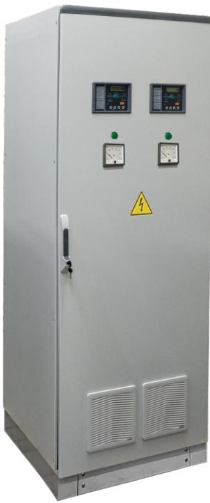
**Зарядно-выпрямительное устройство тиристорное серии ВТ (ЗВУ-ВТ)** представляет собой зарядно-подзарядное устройство с выходами постоянного напряжения, предназначенное для питания потребителей и параллельной работы со стационарными открытыми свинцово-кислотными АБ, герметизированными свинцово-кислотными АБ с рекомбинацией газа и никель-кадмийевыми АБ.
